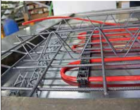
Bauteilaktivierung kann bei guter Dämmung herkömmliche Heiz-/Kühlsysteme ersetzen.
